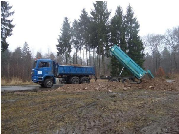
Abb. 5: Lieferung der Ton/Steinmischung; Abladen des Anhängers.
