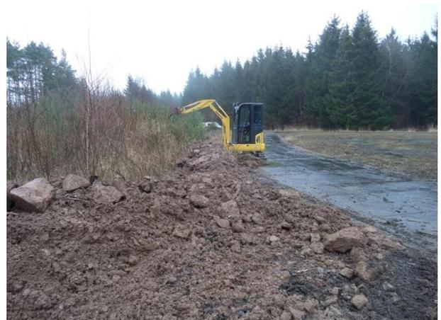
Abb. 6: Beim Verteilen und Einbauen der Ton/Steinmischung mit dem Kettenbagger.
