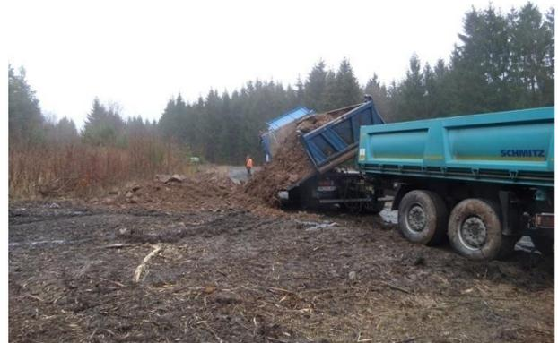
Abb. 4: Lieferung der Ton-/Steinmischung.
